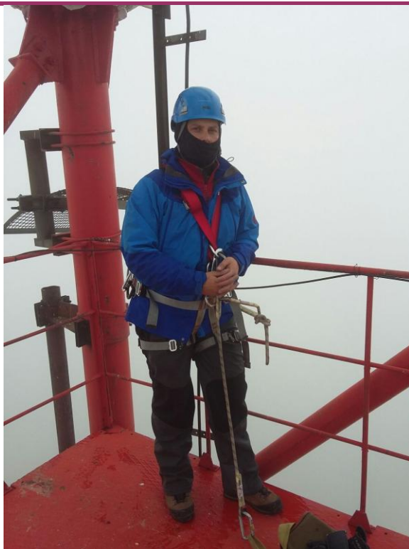
Alpinist utilitar echipat și asigurat corespunzător, pregătit pentru intervenție
