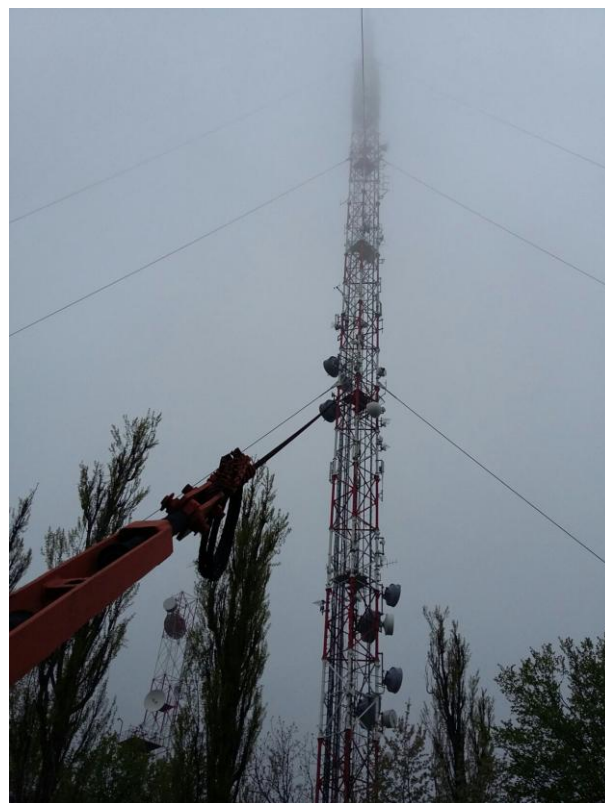
Sisteme de antene instalate de alpișiștii utilitari
