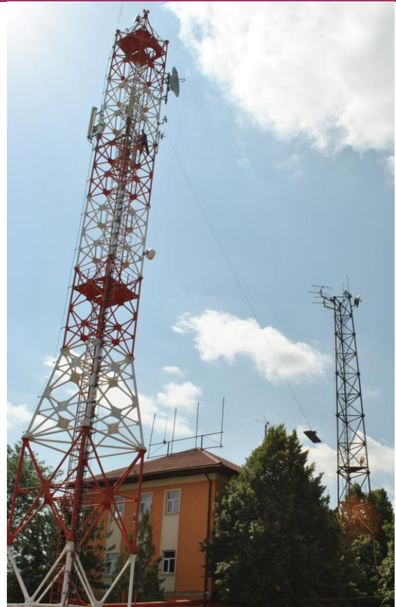
Instalarea pe pilon a unei antene de stație radio
