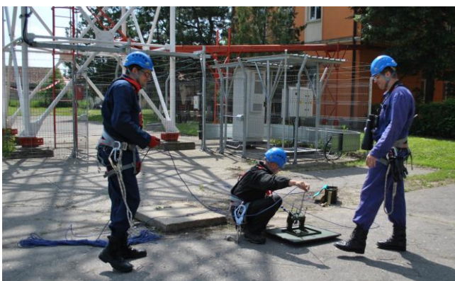
Pregătirea și asigurarea antenei care urmează să fie instalată pe pilon
