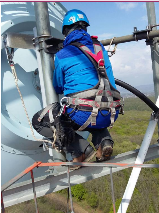
Instalarea pe pilon a unei antene de radio-releu
